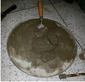
Figura 1. Preparo de traço até atingir a consistência adequada.
