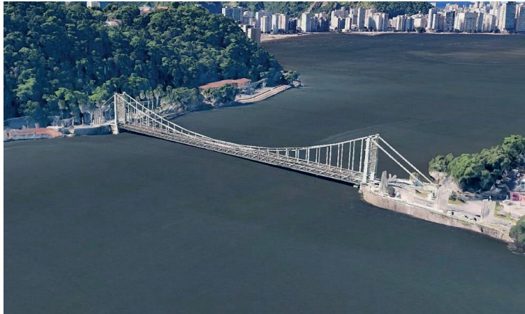
Figura 10 - Ponte Pênsil de São Vicente
