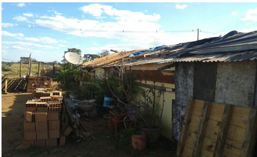
Figura 1: Moradia precária na Cidade de Deus: dignidade ou exclusão?
