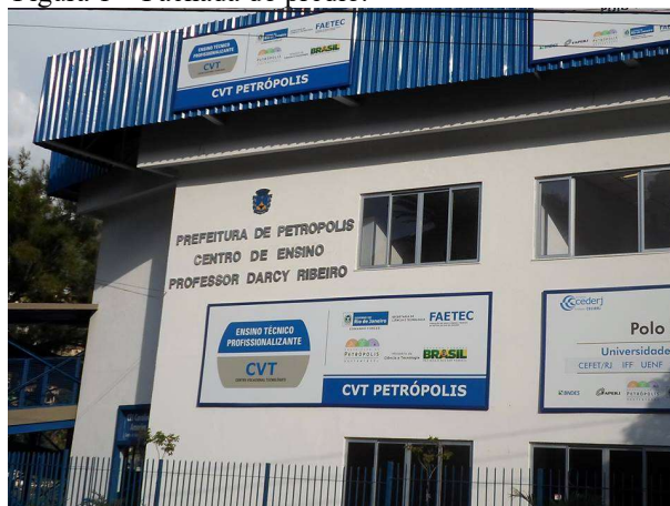
Figura 1 – Fachada do prédio.
