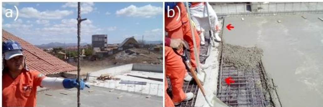
Figura 4 – Mecha metálica (a) e sua utilização (b)
