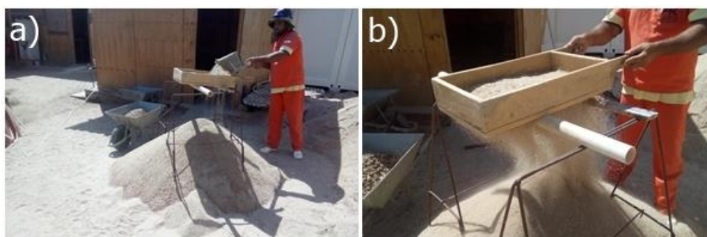
Figura 3 – Peneira rolante (a) e sua execução (b)
