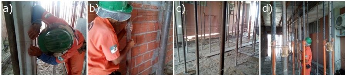
Figura 5 – Referência padrão (a), marcação da cota nas escoras (b), linha de náilon percorrendo as escoras (c) e aferição da cota de altura (d)
