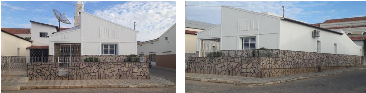
(a) (b) Figura 02: (a) Fachada frontal e (b) lateral da “Residência antiga”.
