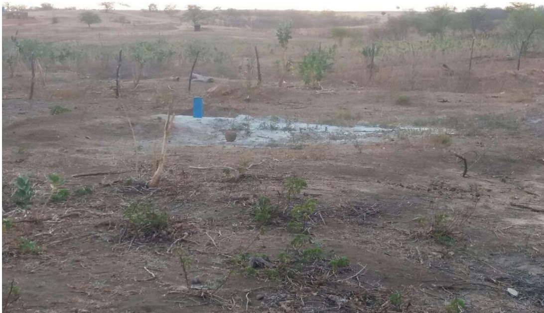
Figura 02 - Poço Artesiano – Zona rural de Pilões/RN
