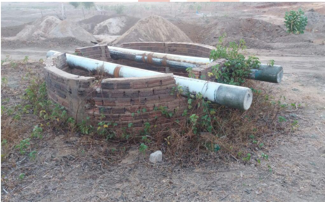
Figura 03 - Poço Amazonas – Zona rural de Pilões/RN
