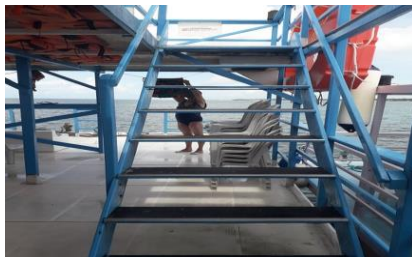
Figura 7: Escada de acesso ao pavimento superior.
