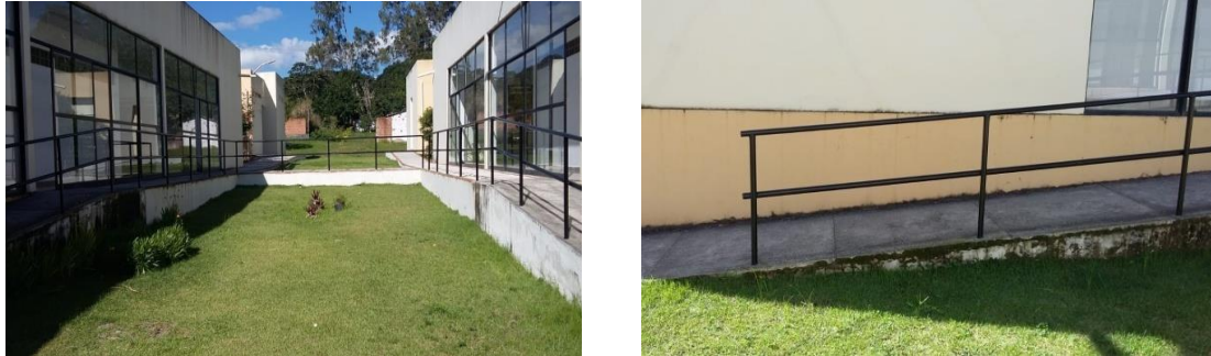
Figura 10. Rampas de acessibilidade e interligação das salas no prédio da biologia.
