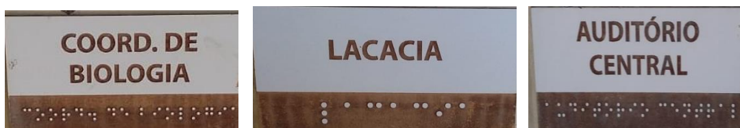
Figura 8. Placas de localização em Braille, instaladas no prédio central da instituição.
