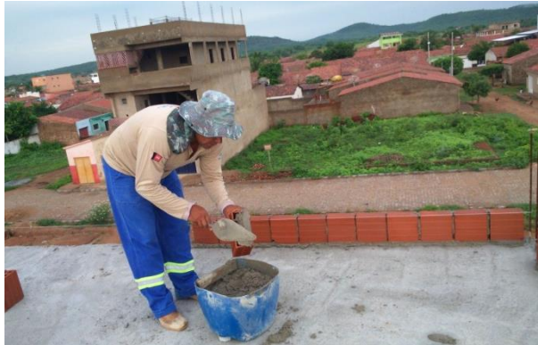
Figura 05: Aplicação das técnicas de esquadreamento na formação da alvenaria
