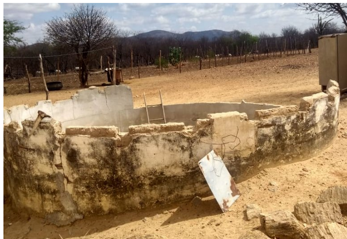
Figura 4: Exemplo de cisterna inoperante na comunidade do Mocambo.
