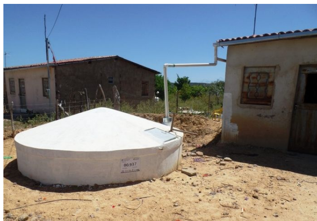
Figura 1: Cisterna construída pelo P1MC
