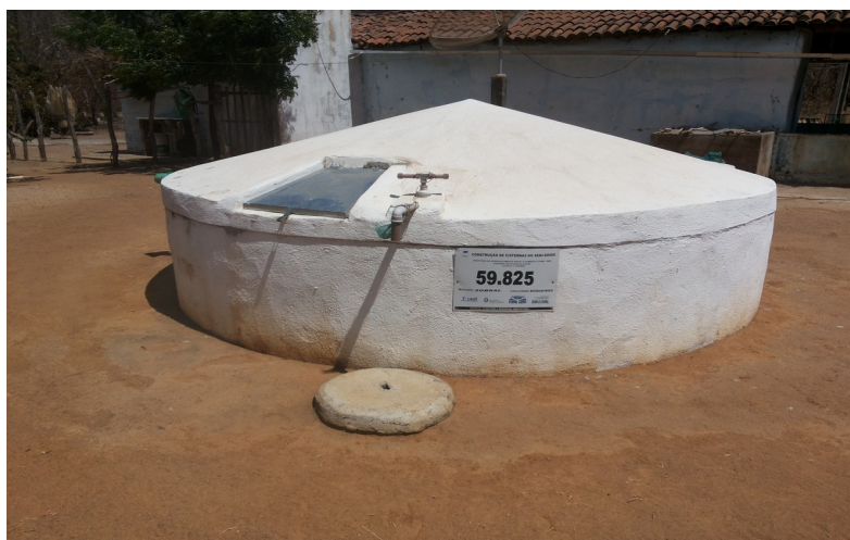
Imagem1: Cisterna de Placa na comunidade de Boqueirão. Fonte: autores (2014)
