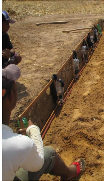
Figura 4: SISCAFI sendo colocado no solo, com auxílio da estrutura de madeira (ripas).
