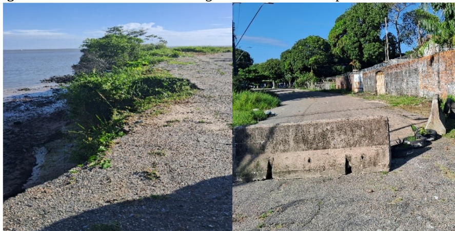
Figura 4: trechos da Av. Beira mar degradados e interditados por conta da dinâmica de marés.
