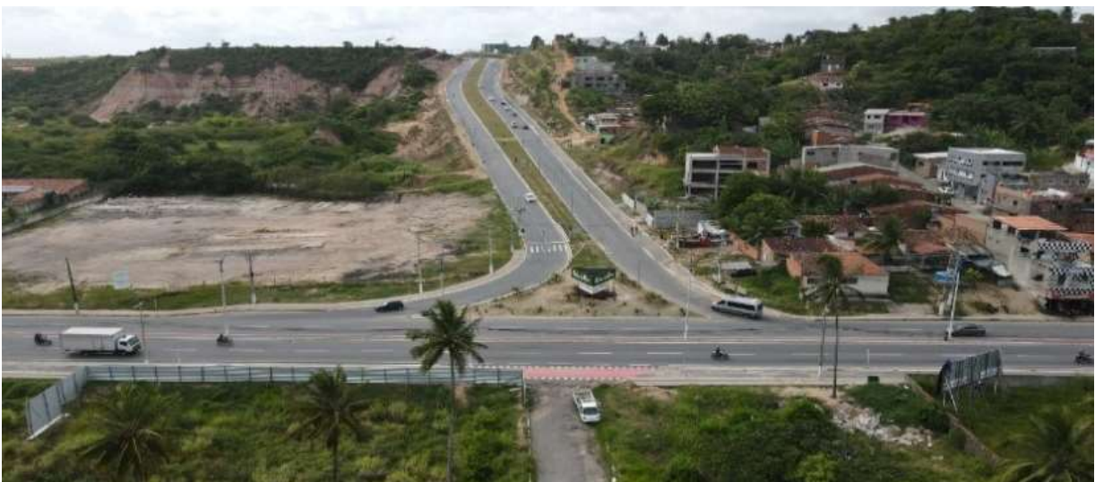
Figura 2 – Rota do mar no início da Rodovia AL-101 Norte
