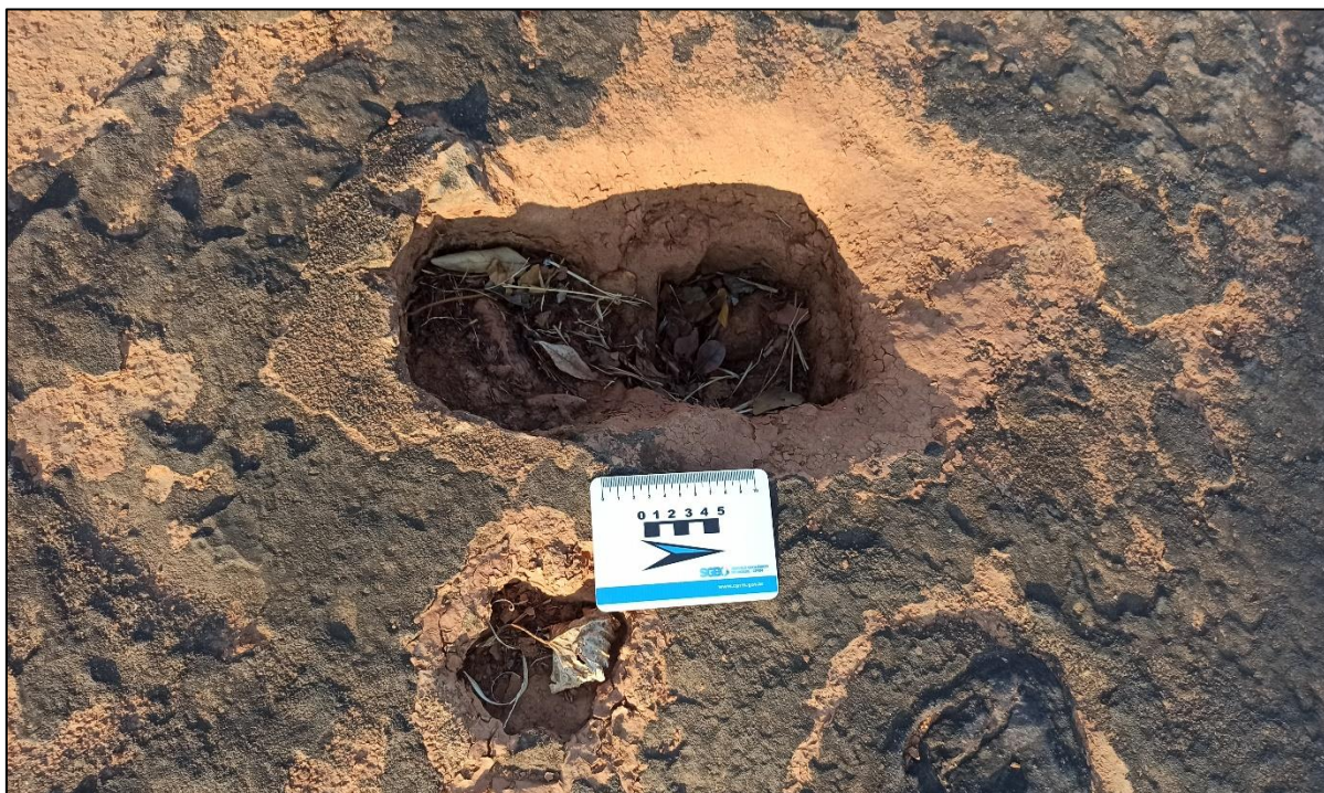
Figura 6 – Perfurações no pavimento estriado (ação antrópica)
