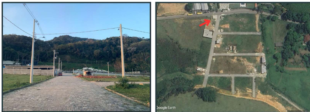
Figura 2 - Condomínio de lotes em construção no bairro de Xerém
