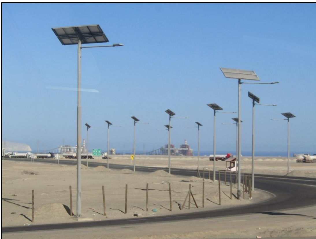
Foto 2: Entrada do Complexo Portuário Mejillones
