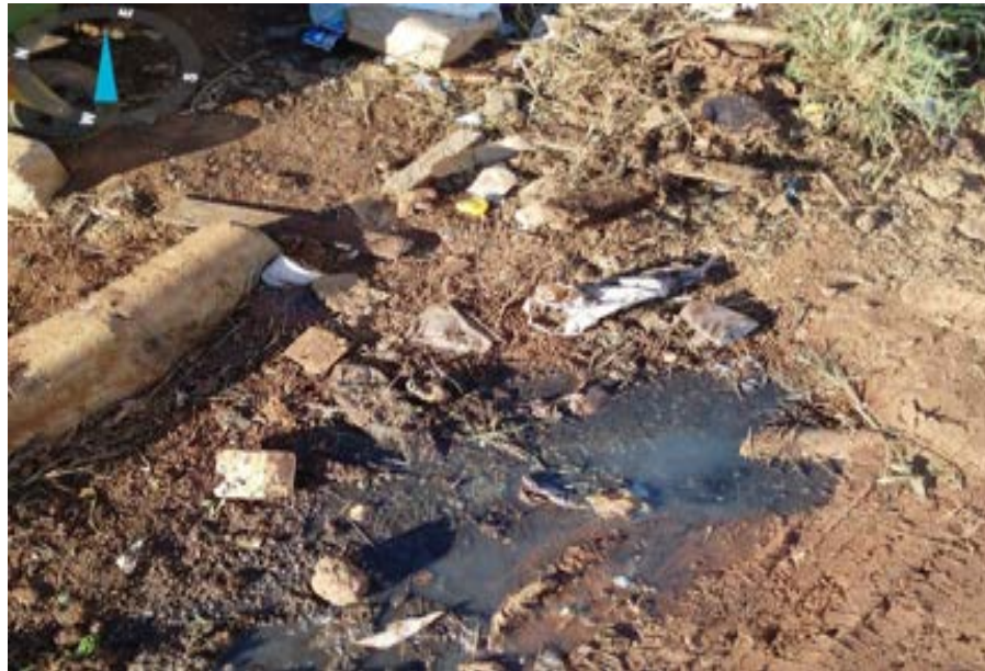
Figura 3 –Esgotamento a céu aberto no Bairro Prisco Viana em Caetité-2025
