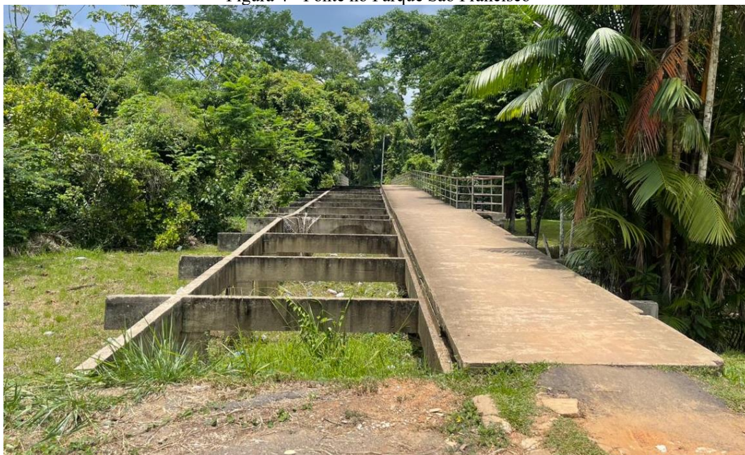
Figura 4 - Ponte no Parque São Francisco
