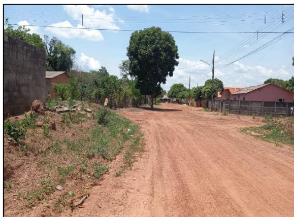
Figura 7 - Rua sem pavimentação asfáltica no bairro São Jorge em Cáceres (MT)
