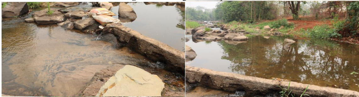
Figura 7. Barragem na seção 4
