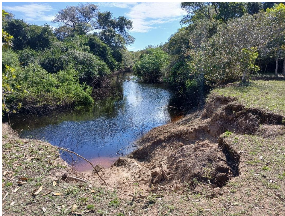
Figura 3: Processos Erosivos as margens do Rio Abobral. Fonte: Trabalho de Campo, 2025.
