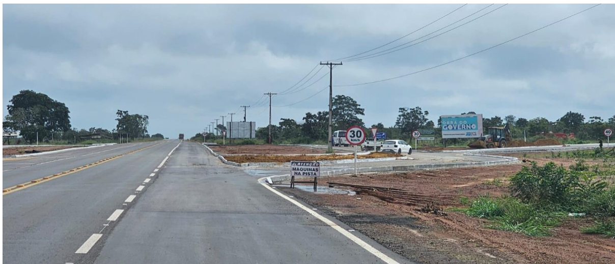
Foto 1: Encaixe de interligação entre as rodovias AP-070 e BR-210.
