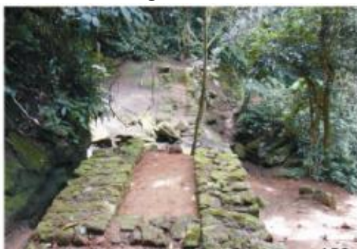
Destaque do muro duplo de contenção da barragem destruída
