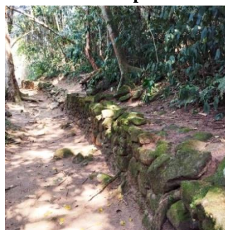
Trecho adiante da Pedreira próximo ao complexo construtivo de patamares
