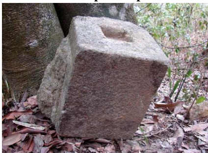
Suporte de granito trabalhado na técnica de pedra aparelhada
