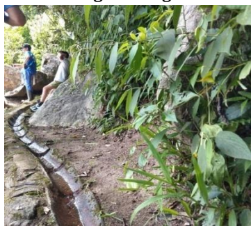
Detalhe de trecho das canaletas que drenam cursos d'água para a antiga barragem
