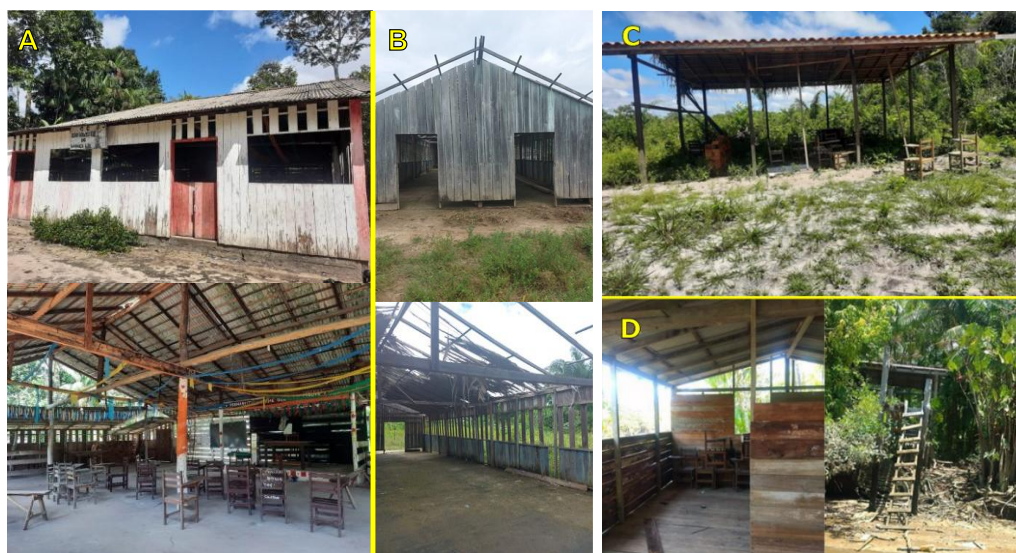
Figura 5 - Escolas Classificadas como "Construir (Sem Prédio)": A) E.M.E.I.F. de Mangabal (61); B) E.M.E.I.F. São João do Cupijó (134); C) E.M.E.I.F. de Marinteua (Umapijó) (44); D) E.M.E.I.F. de Praia Grande (178).
