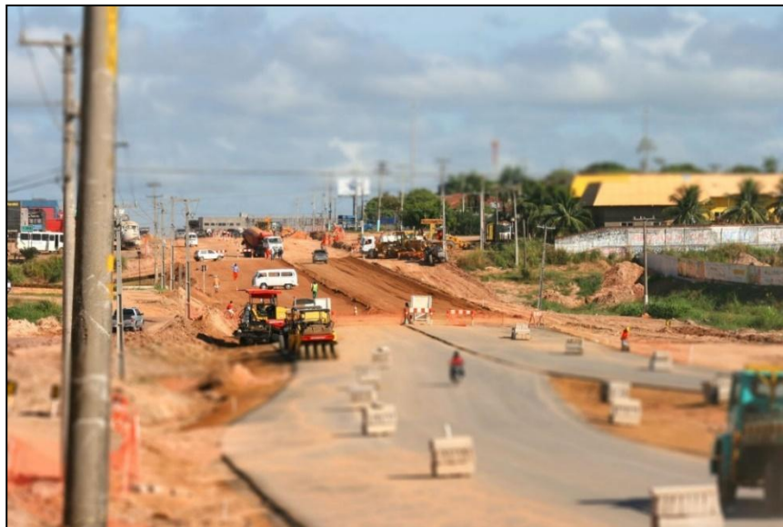
Figura 6. Obras da duplicação da rodovia Transamazônica em Marabá (2011).
