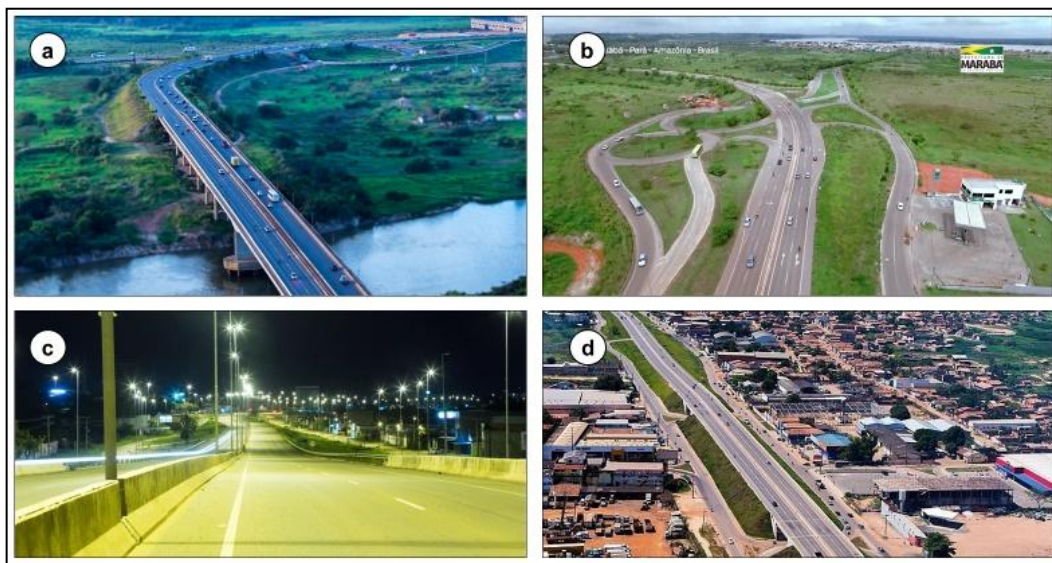
Figura 08. Entroncamento entre os núcleos após a duplicação da Transamazônica.
