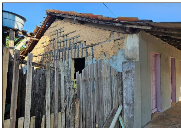
Figura 2: Detalhe lateral da Casa da dona Preta, evidenciando estrutura em madeira e barro (pau-a-pique).
