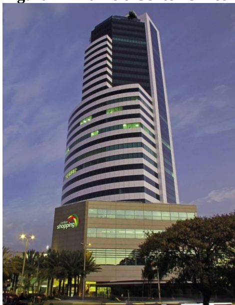
Figura 2 – Edifício Center Office
