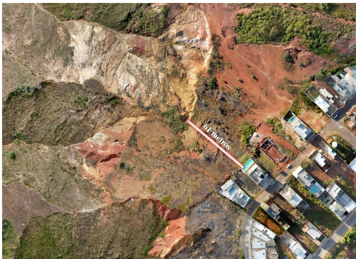
Figura 6: Distância entre a voçoroca e uma das edificações da área de estudo.
