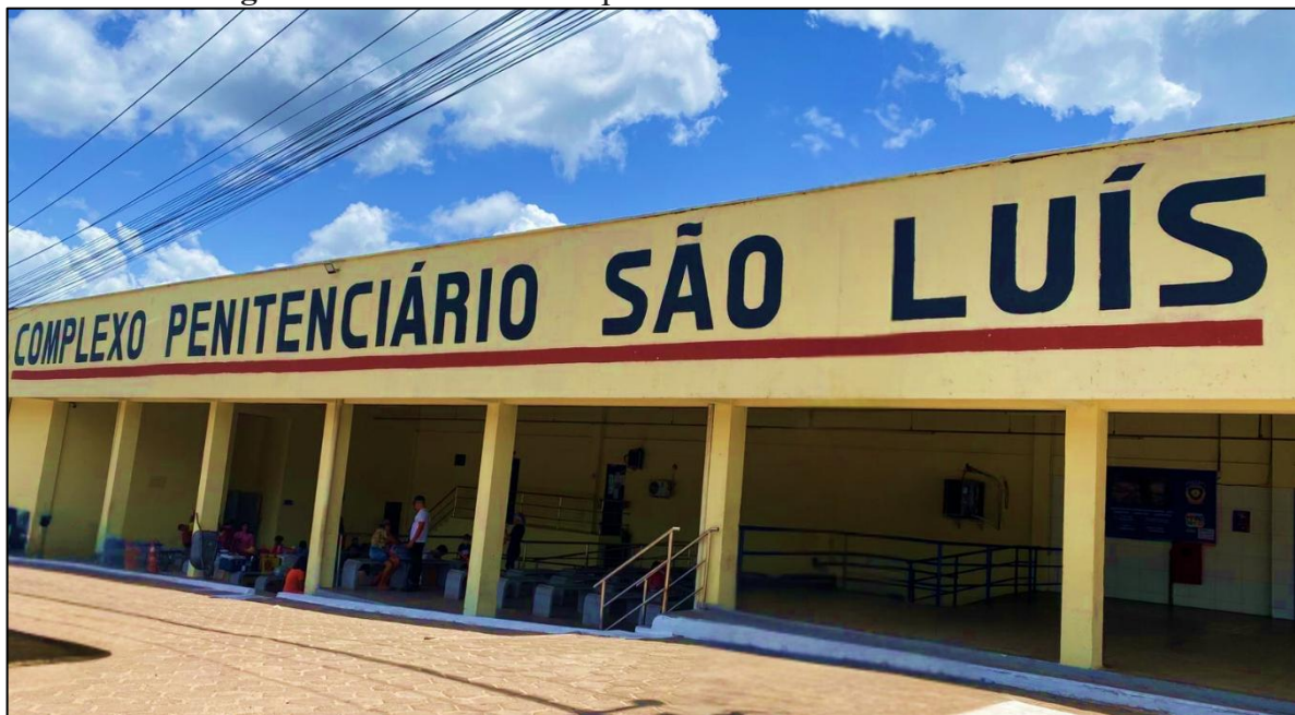
Figura 2 - Fachada do Complexo Penitenciário São Luís – MA
