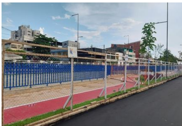
Figura 03 - Quadra concluída da Nova Tamandaré
