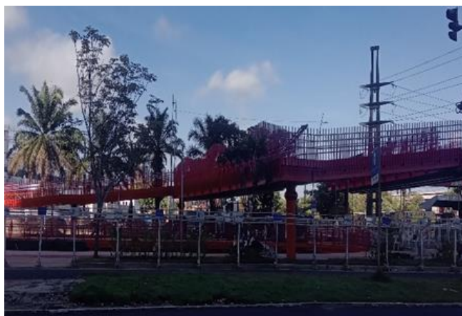
Figura 02 - Passarela da Nova Doca
