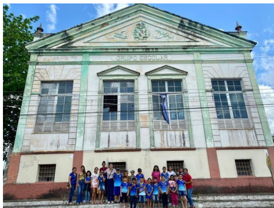
Figura 1 – Fachada da Escola Ângelo Cezarino
