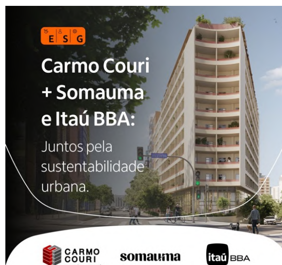
Figura 4 - Release do Empreendimento retrofit do Edifício Virgínia (1951) realizado pela incorporadora Somauma com financiamento do Itaú BBA
