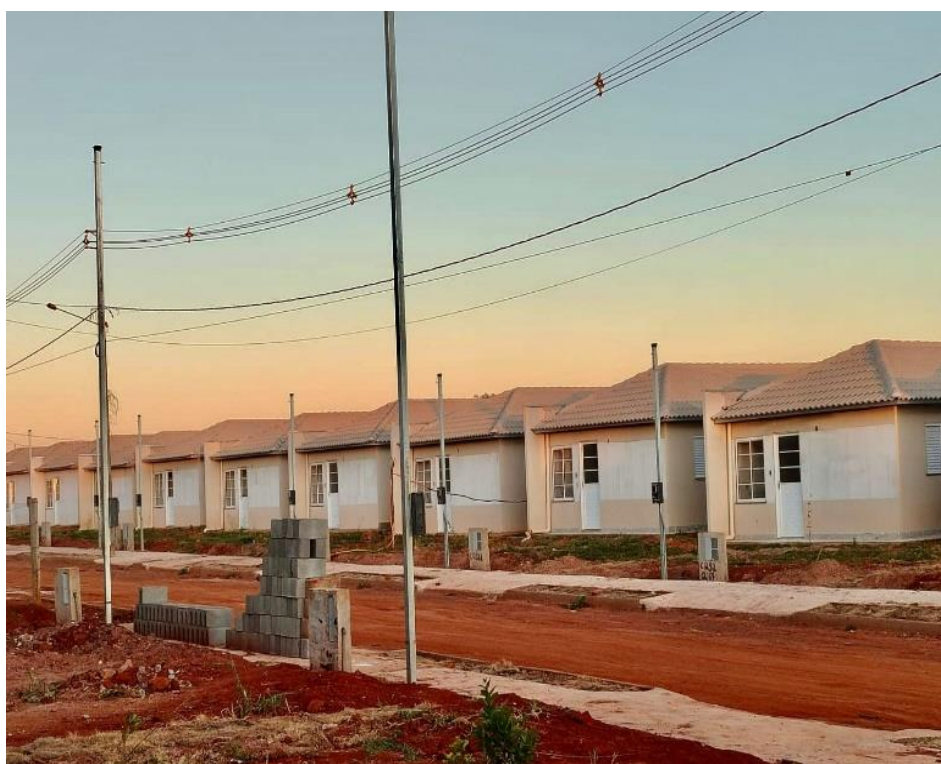
Figura 1 - Conjunto habitacional pelo MCMV em construção no setor Novo Horizonte III. Fonte: Kálita Cristina Cunha Silva (2025).
