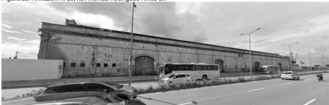
Figura 15: Armazém n. 10, na Avenida Rodrigues Alves s/n
