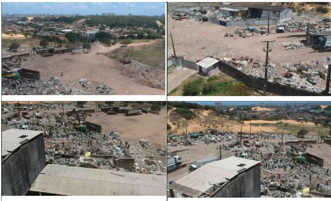
Figura 3: Estação de transbordo de Cidade Nova (antigo lixão da capital), Natal/RN.
