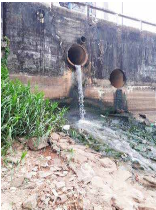
Figura 2 – Despejo do esgoto.
