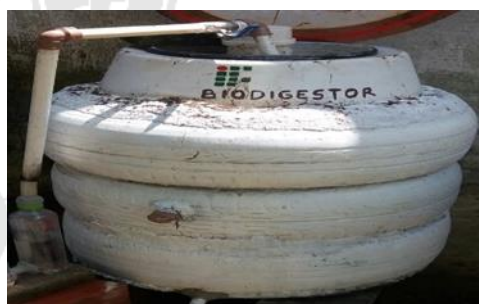
Figura 01: Biodigestor construído de materiais reciclados
