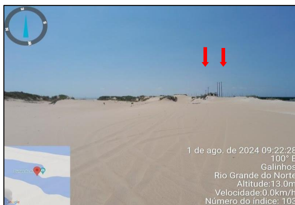
Figura 4. Postes elétricos instalados em áreas de dunas e ameaçados pelo avanço das dunas móveis.
