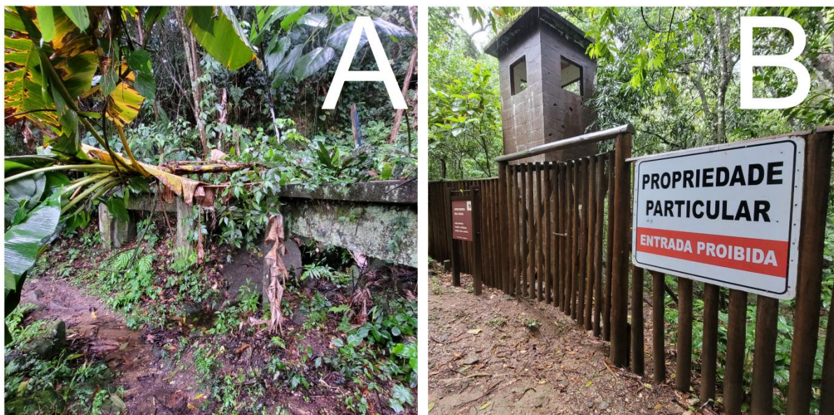
Figura 4. Estruturas relativas à captação de água. A, Aqueduto associado à queda de árvore e escoamento superficial no leito da trilha. B, propriedade particular pertencente à Vale S.A. Fotos: Marcelo Roriz (2024).
