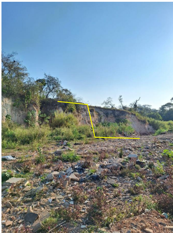
Figura 2 - Talude erosivo voçorocamento do Córrego do Socego, aterramento do córrego com materiais sólido (antropogênicos). Registro em campo, agosto de 2024.
