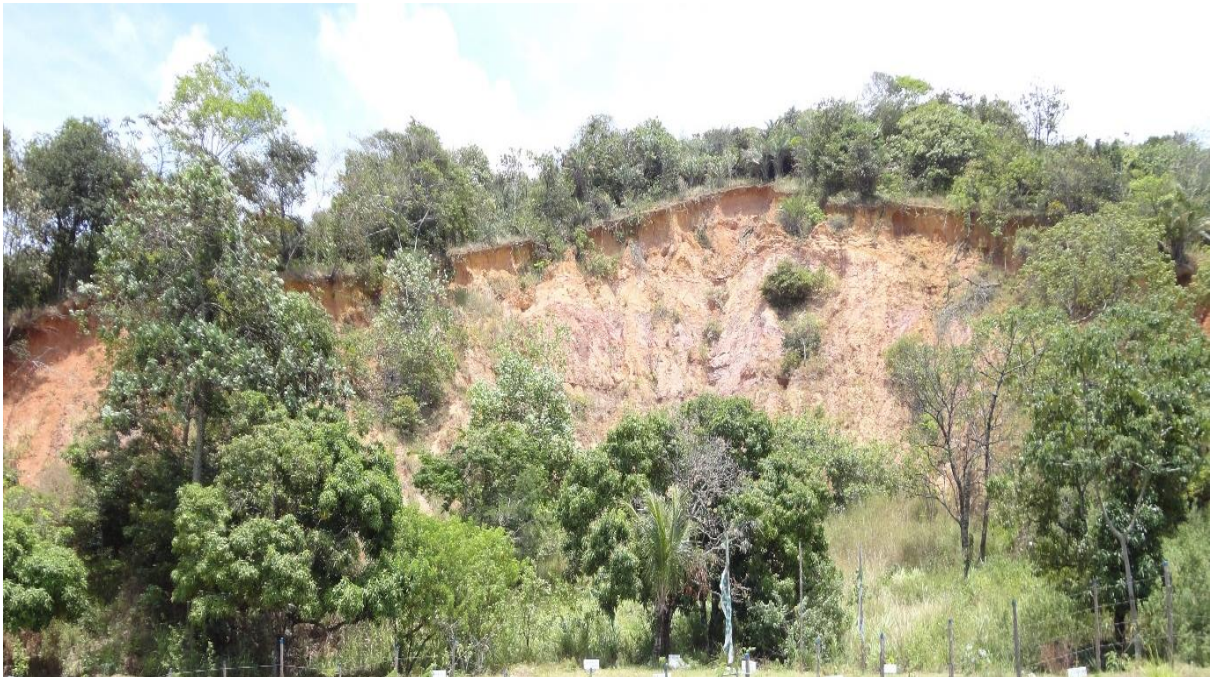
Figura 02: Evolução do escoamento superficial pela concentração do fluxo de água no interior de voçoroca originada após movimento gravitacional de massa associado aos escorregamentos translacionais (estágio 2) no bordo leste do Morro do Urubu, Bairro Porto Dantas.
