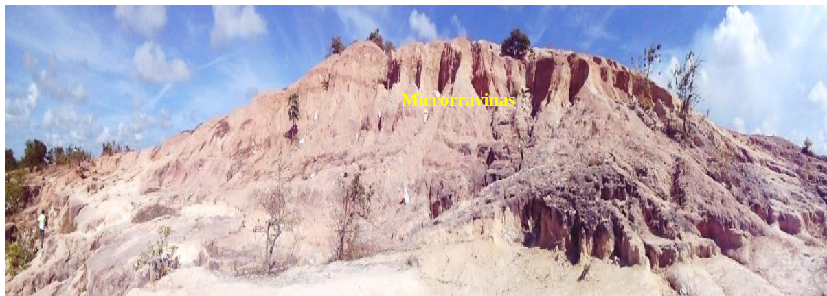
Figura 05 – Vista panorâmica de encostas sem o revestimento da cobertura vegetal, exibindo o desenvolvimento de microrravinas (terceiro estágio), entre as ruas D e São Francisco no Bairro Cidade Nova.
