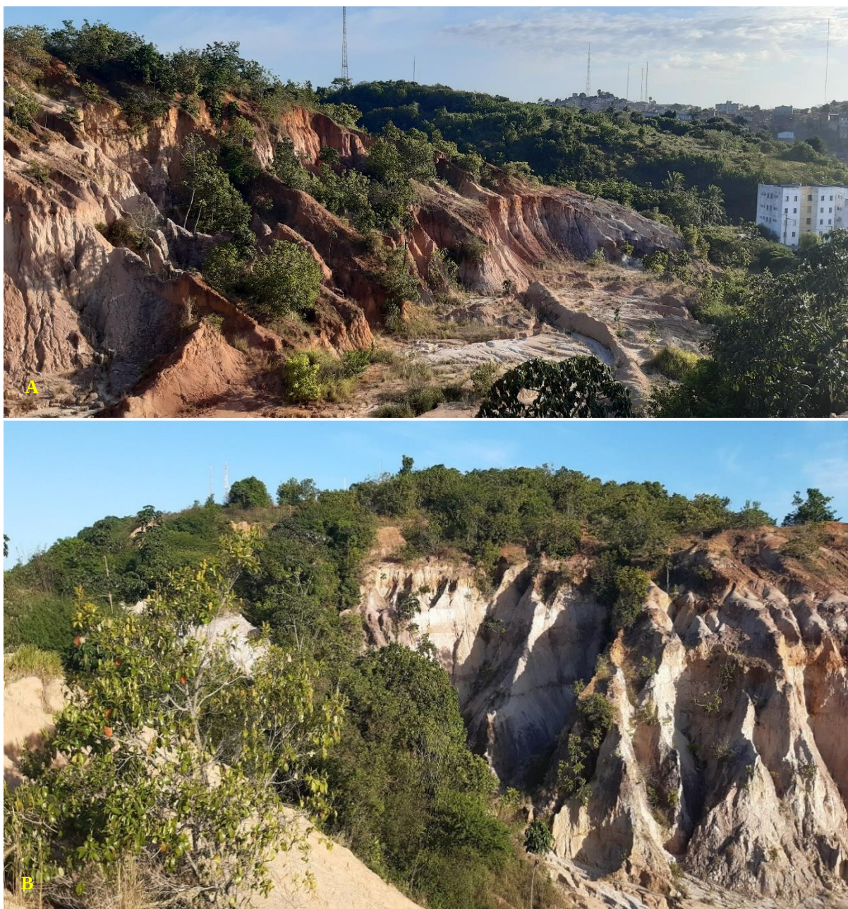
Figura 04: A e B – Formação de ravinas e microrravinas denunciando processo erosivo mais crítico do estágio 2 com tendência ao voçorocamento em encostas de topo convexo no bordo oeste do Morro do Urubu, Bairro Porto Dantas. Predomínio das cores vermelho-amarelada devido à presença de óxido de ferro, silício e alumínio.
