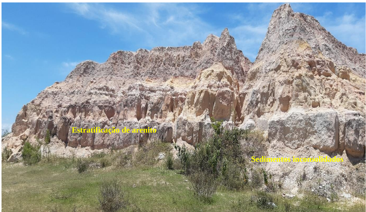
Figura 03: Efeitos do escoamento superficial concentrado em encosta íngreme da rua São Francisco, Bairro Cidade Nova. Observa-se a presença de fissuras longitudinais nos terços médio e inferior, além dos depósitos de sedimentos arenoargilosos inconsolidados e não coesivos pela exposição à chuva. em toda extensão da base, no limite com a estratificação de arenito.
