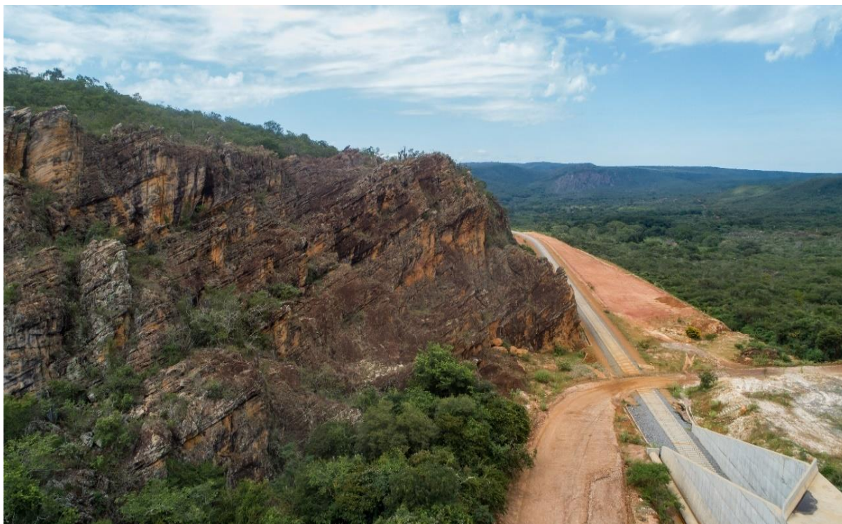
Figura 2 – Vista aérea da passagem inferior, Brejinhos das Ametistas, Caetité – BA, 2024.
