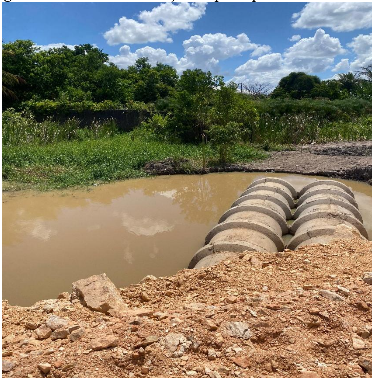
Figura 5. Obra de Urbanização na principal nascente do Riacho Piauí
