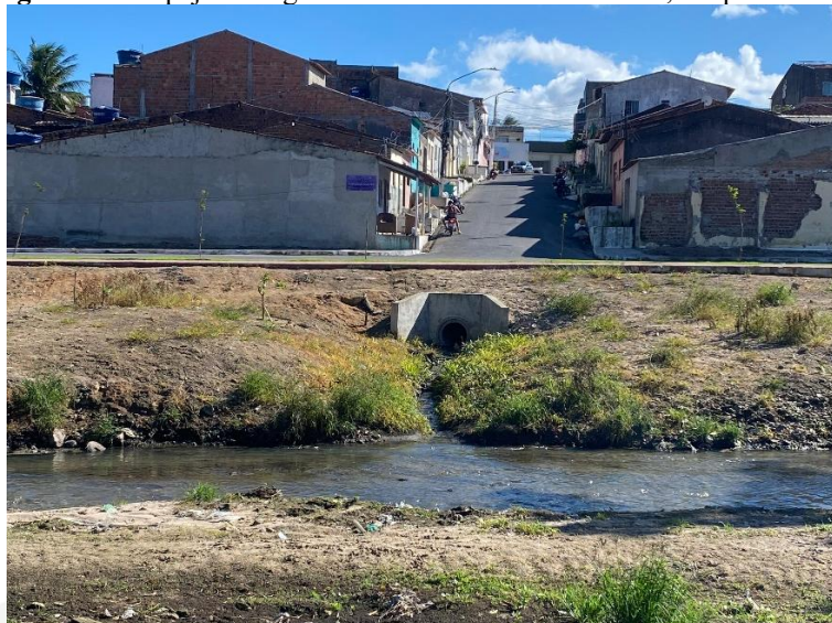
Figura 3. Despejo de esgoto em trechos do Riacho Piauí, Arapiraca - AL
