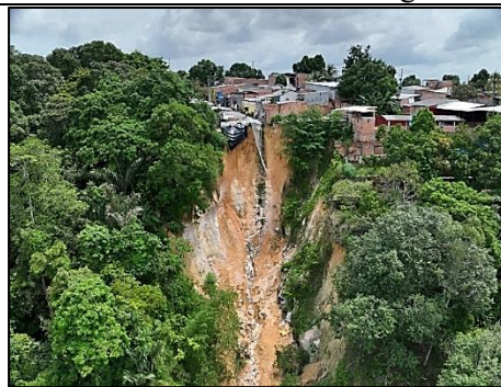
Risco de Erosão e Deslizamento
