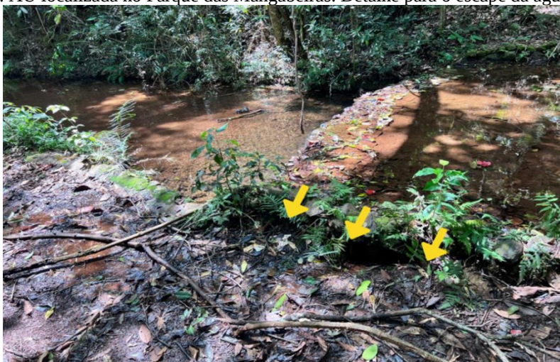
Figura 2: AU localizada no Parque das Mangabeiras. Detalhe para o escape da água barrada
