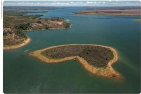
Figura 4 – Área alagada do reservatório da Usina Hidrelétrica Corumbá IV (Abadiânia-GO), 2021.
