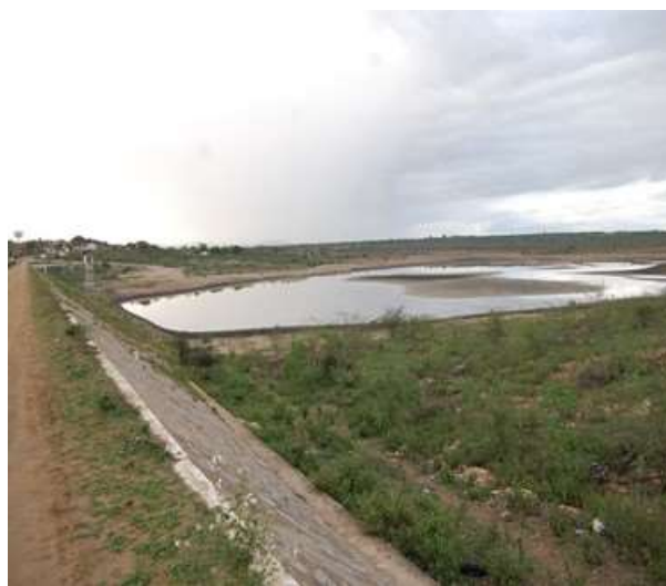
Figura 04. Aspecto panorâmico do barramento do Açude do Estado, Soledade-PB. Fonte: Autores, Julho de 2015.
