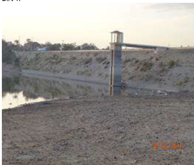
Figura 03. Aspecto panorâmico do barramento do Açude do Estado, Soledade-PB. Fonte: Autores, fevereiro de 2014.
