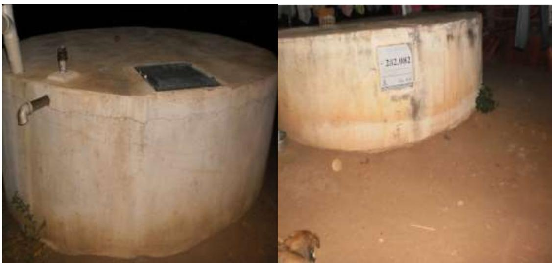
Cisternas de placas com capacidade para armazenar 16.000 litros.
